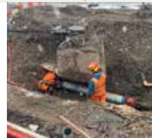
S. 81: Abteilung Tiefbau
