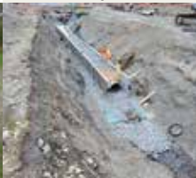
S. 78: Abteilung Tiefbau
