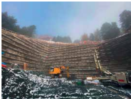
Grosse Baugrubensicherung im Gebiet Suvretta (Foto: Abteilung Hochbau, Daniele Rogantini)
