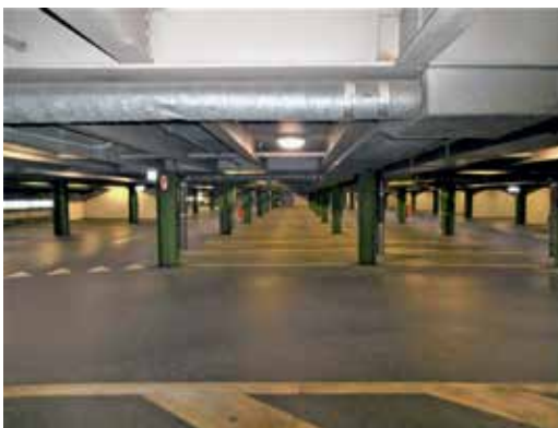
Baufortschritt PH Quadrellas 2023
