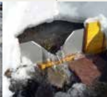
S. 80: Abteilung Tiefbau
